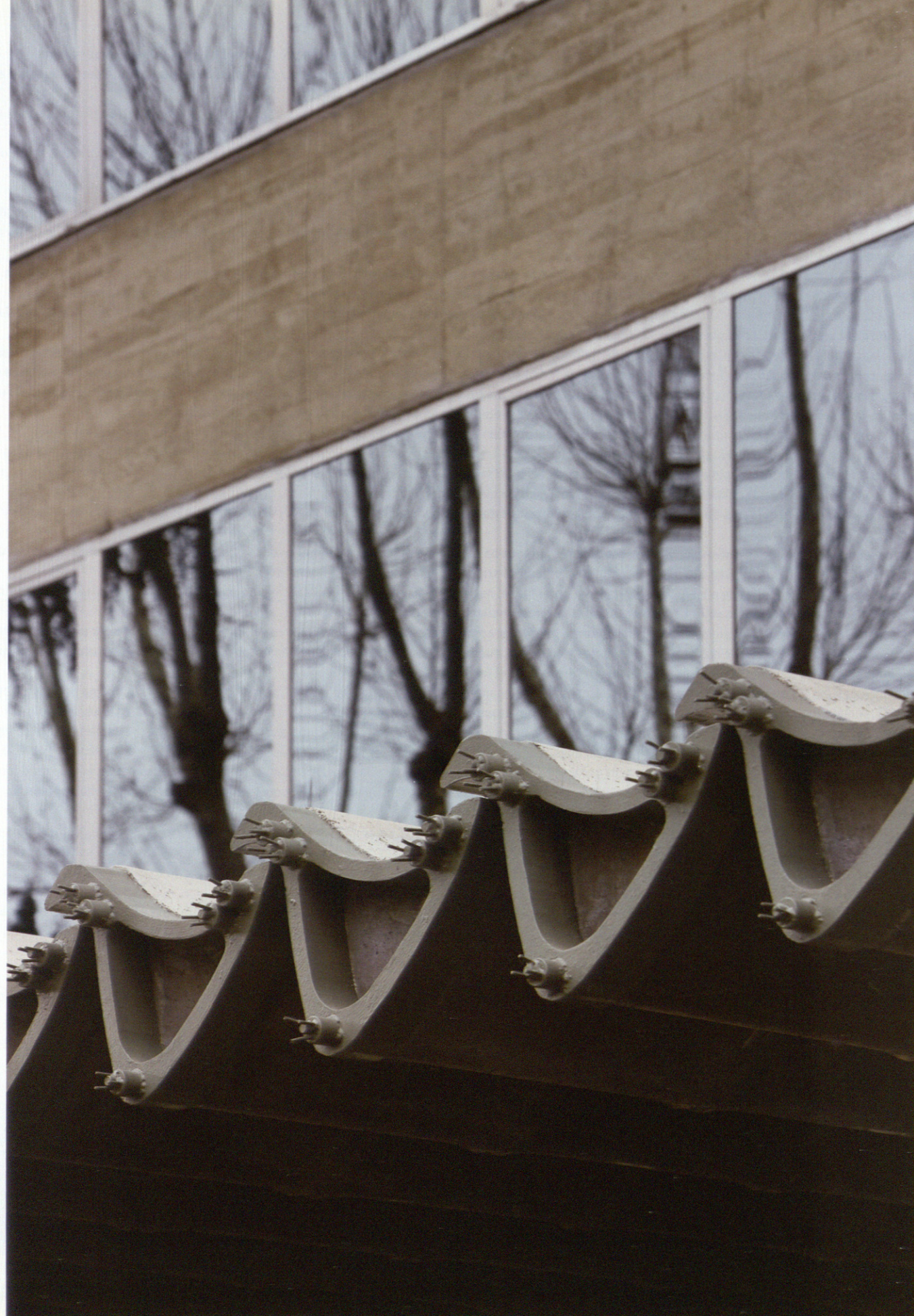
Cubierta de acceso al bloque de administración y despachos técnicos. Centro de Estudios Hidrográficos del CEDEX. Miguel Fisac 1963. Fotografía: Alfonso Quiroga. Covered access to the administrative section and technical offices, CEDEX Hydrographic Studies Center, Miguel Fisac, 1963. Photo: Alfonso Quiroga.
