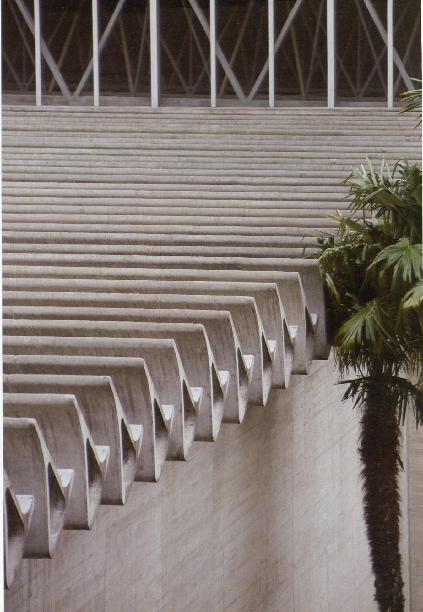
Cubierta de la nave de modelos y ensayos, Centro de Estudios Hidrográficos del CEDEX. Miguel Fisac 1963. Fotografía: Alfonso Quiroga. Models and trials nave roof, CEDEX Hydrographic Studies Center. Miguel Fisac, 1963. Photo: Alfonso Quiroga.
